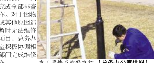
电工师傅在检修电灯。(总务办公室供图)
